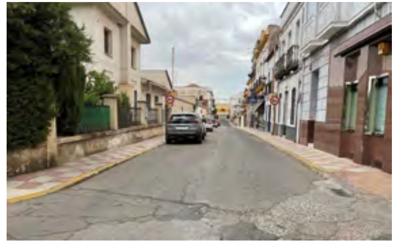
La nueva adjudicación de las obras permitirá arreglar las calle Constitución y Miguel Vigara
